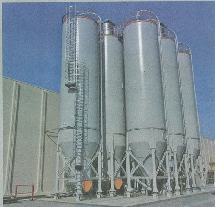
Silos contenant les matières premières: titane, craies et sables divers.
